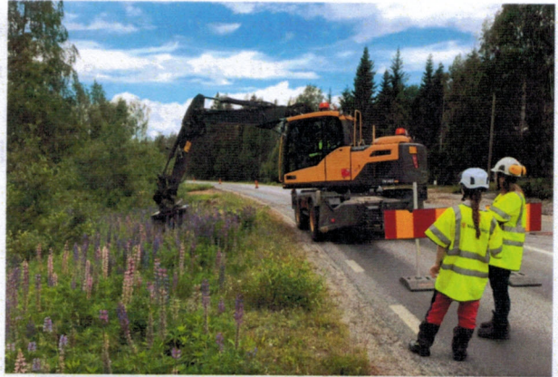
Lupinerna kommer grävas upp med grävmaskin. Foto: Charlotta Olofsson, Trafikverket.
