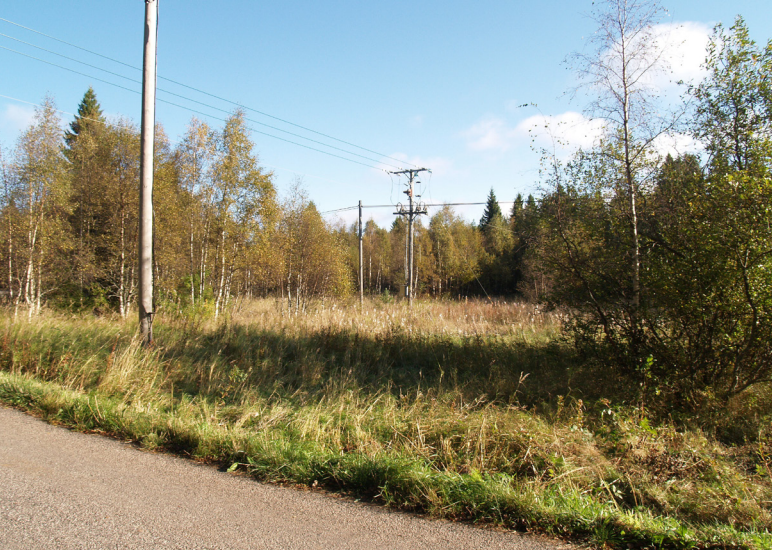
Kraftledningen till Stora Fjäderägg kommer att läggas i markkabel. Foto: Kurt Edlund.
